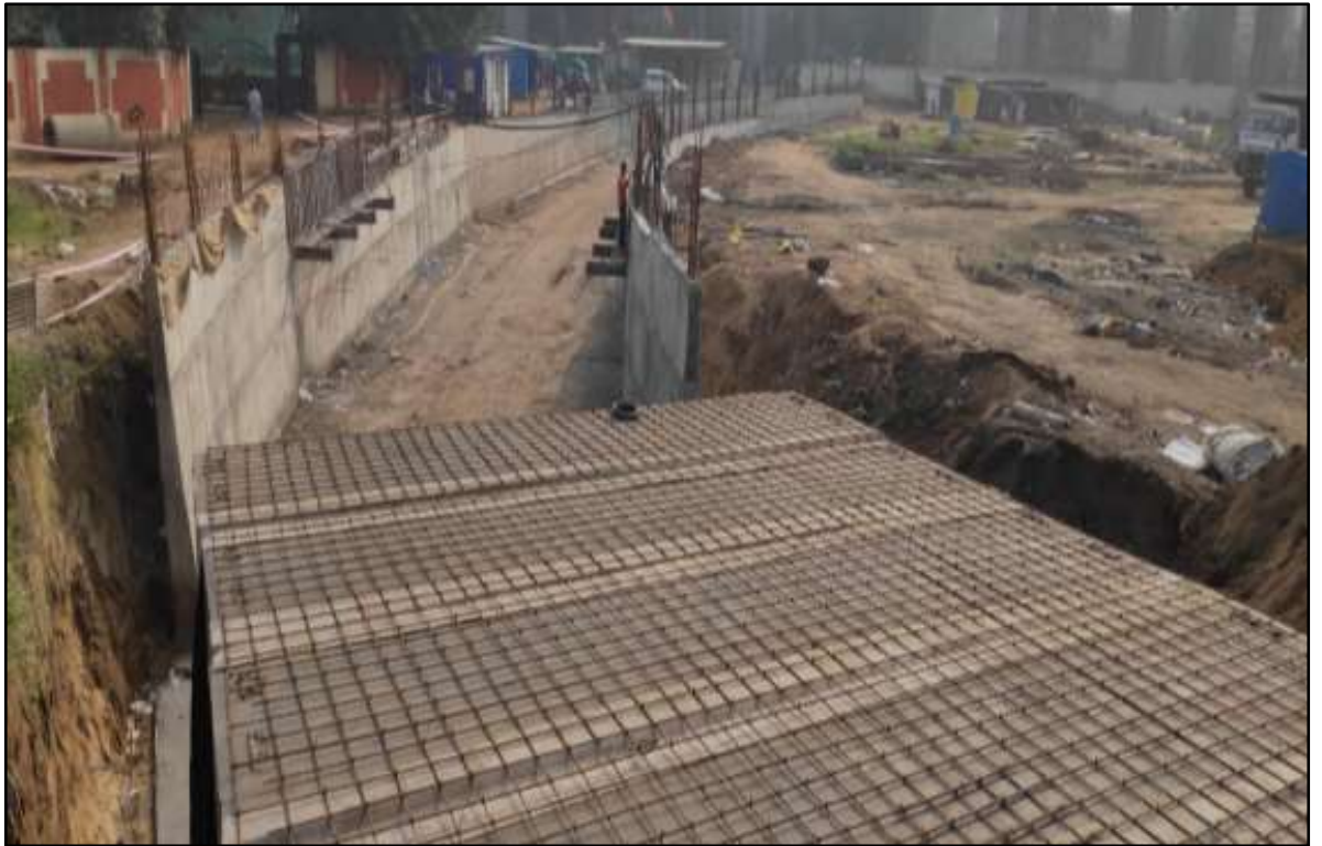
पुल 1 के तहत सड़क - निर्माणाधीन - चिमनभाई पुल की ओर जाने का रास्ता, अहमदाबाद, गुजरात
