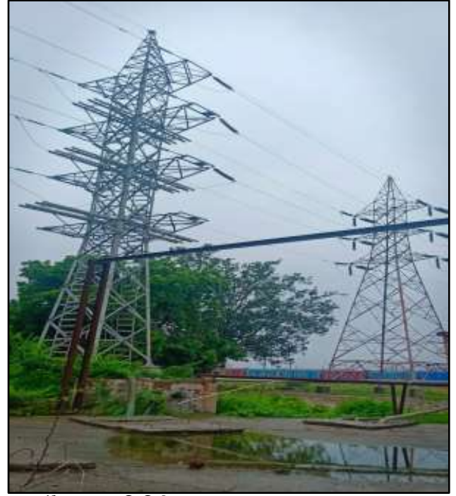
टॉरेंट पावर लिमिटेड द्वारा वातवा, अहमदाबाद, गुजरात में टॉवर की स्थापना और स्ट्रिंगिंग कार्य
