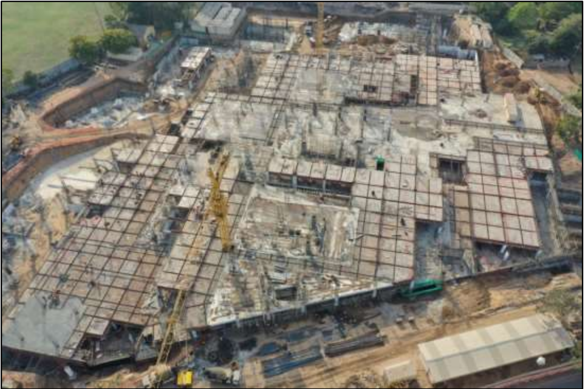
यात्री टर्मिनल हब, साबरमती, गुजरात में भू तल स्लैब का निर्माण कार्य प्रगति पर
