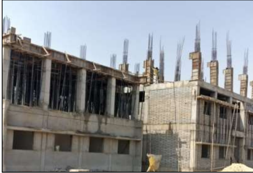
ब्रिज, वर्कशॉप, अहमदाबाद के प्रशासनिक भवन में स्लैब और स्तंभ, सुदृढीकरण और आरसीसी का कार्य प्रगति पर
