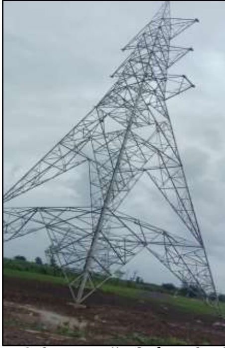
220 केवी लाइन का टॉवर निर्माण (यानी वापी / खरपद और वापी / मंगलवाडे क्रॉसिंग चनेज (169.334) वापी, गुजरात
